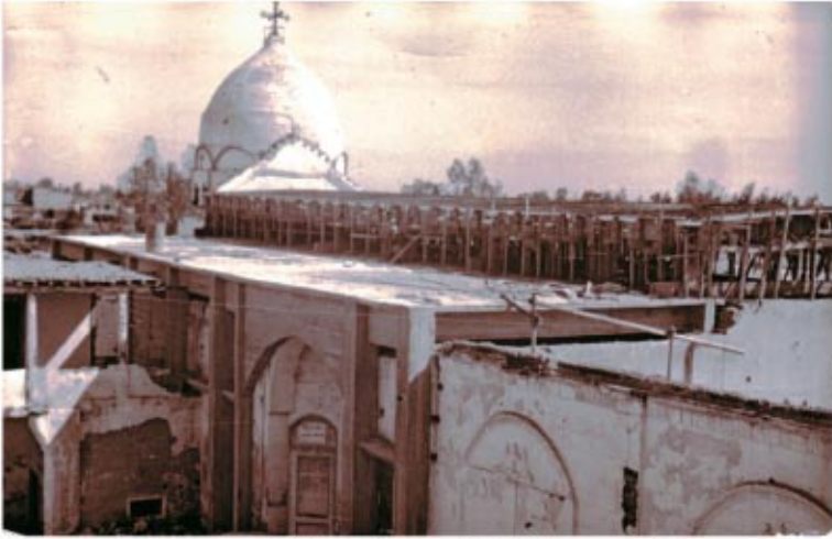
صورة من مراحل التعمير وإعادة إنشاء سطح الكنيسة الكبرى بالخرسانة المسلحة، ويظهر الباب البحري للكنيسة
